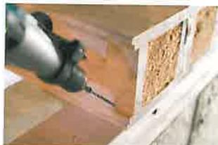
**7 | Jedes Hohlkastenelement wird mit dem Auflager verschraubt.**
