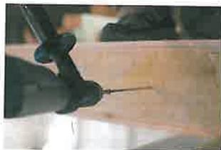
**8 | Seitlich eingedrehte selbstbohende Holzschrauben verbinden die Elemente in horizontaler Richtung.**
