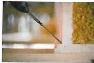
**5 | Das erste Element wird auf dem Auflager mit einer schräg eingedrehten selbstbohenden Holzschraube befestigt.**
